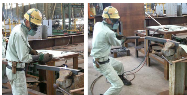
＜山形鋼をバーナーで焼き(左)、曲げる(右)工程＞
